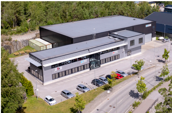
Hoofdkantoor en magazijn
