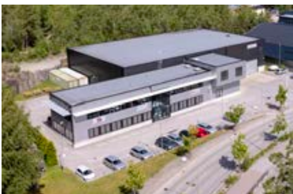
Hoofdkantoor en magazijn
